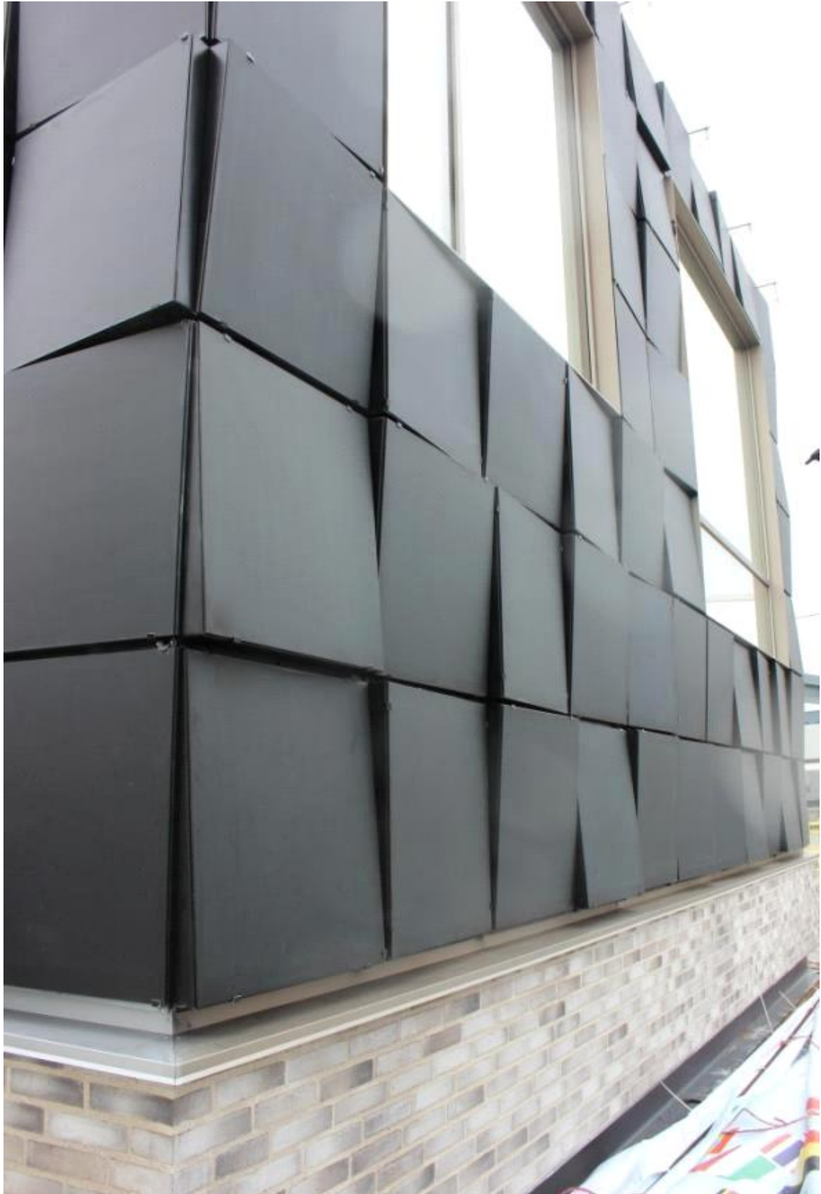
각기 다른 기울기로 설치된 태양광 패널
